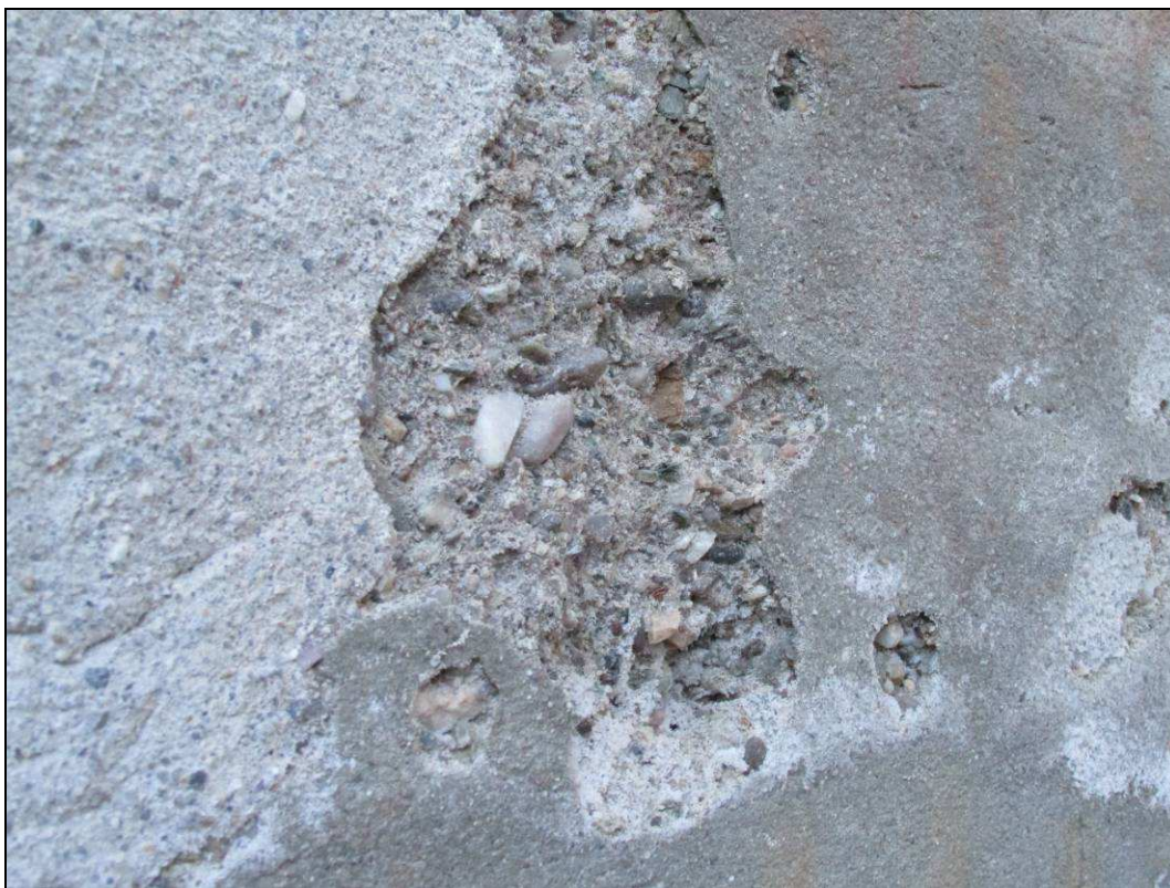
Obr. č. 8 – detail na líce opěry Olomouc - silně zdegradovaný beton při patě klenby, opady do hloubky 1-2 cm
